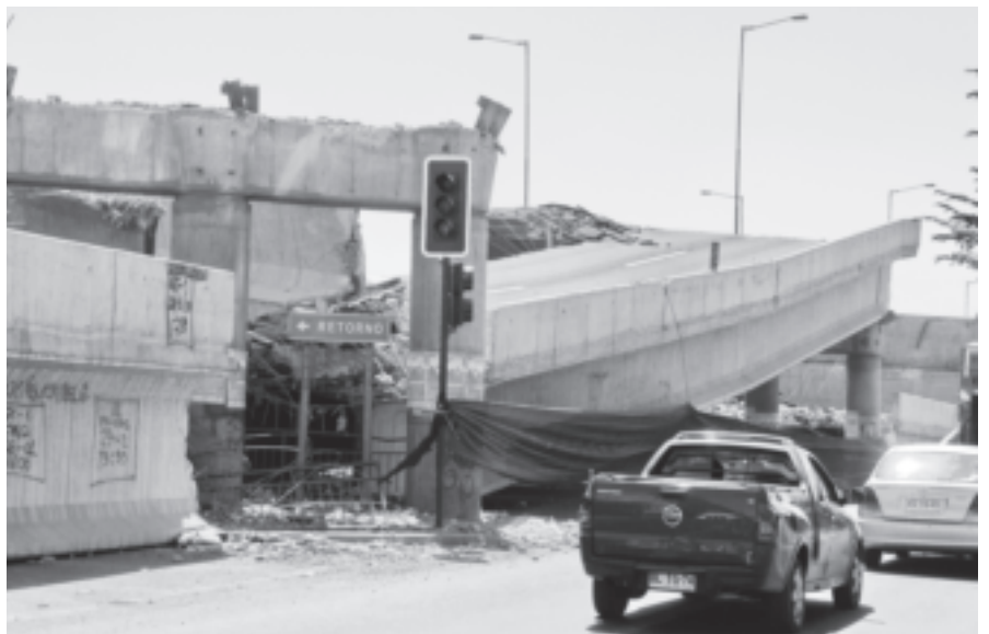
地震直後のサンティアゴの高速道路の様子 (写真提供：ジェトロ・サンティアゴ事務所)
