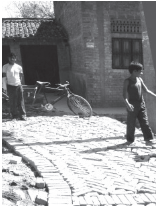
村の小規模公共事業：「カラランジャー」と呼ばれるレンガ舗装による村道（2012年2月26日筆者撮影）
