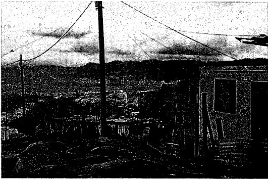
キーバ村から不法接続で配水するホース群
