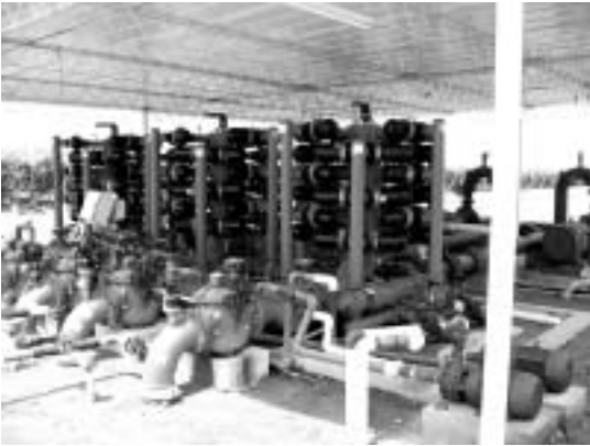
写真3：無線による遠隔操作で点滴灌漑のポンプやバルブを調整する（アグロカサ社ラ・カタリナ農場）
