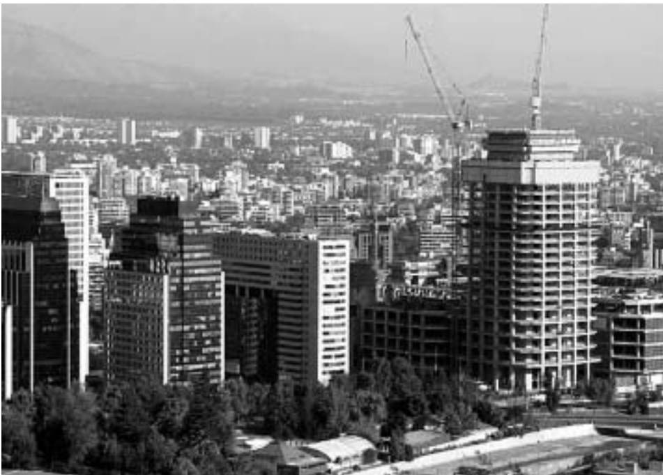
右端が建設中断されたままのセンコスッド社ビル(筆者撮影)
