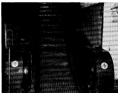
地下鉄の駅につけられた1910年代の木製エスカレーター。現在も活用されている (アエノスアイレス 写真：加賀美充洋)
