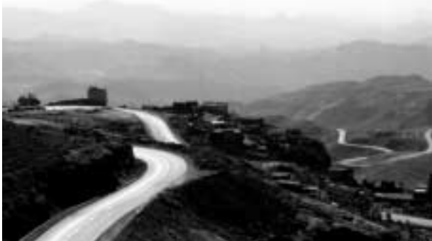
サナア～ホデイダの山岳道路。上り下りとヘアピンカーブの多さは折り紙つきである。この道路は中国政府が多くの中国人労働者の犠牲をはらって建設し、完成の翌年（1962年）に革命が起きた。（ハイマーにて）
