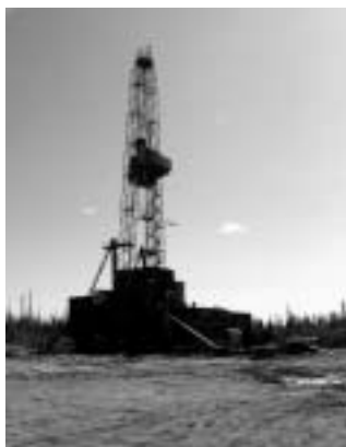
東シベリアのイレリヤフ油田の掘削現場。(筆者撮影)
