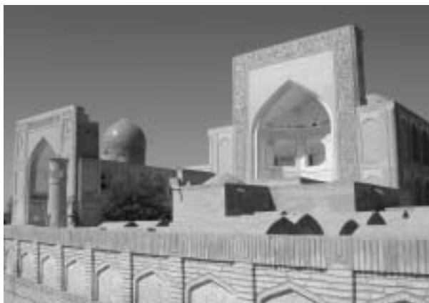
独立後にイスラーム関連の建築の修復が進められた（ブハラ州、2006年撮影）。
