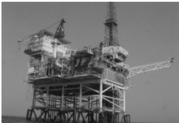
日本の石油開発会社3社の合同になるJHN社が珠江口海域で開発した陸豊13-1油田のジャケット式の生産プラットフォーム、中国の南海東部公司（CNOOCの子会社）とともに、1993年秋に原油生産を開始し、現在でも年間60万トンの生産がある小油田であるが、日本企業が中国陸・海域で原油生産を行なう唯一のものとなっている（石油資源開発（株）提供）
