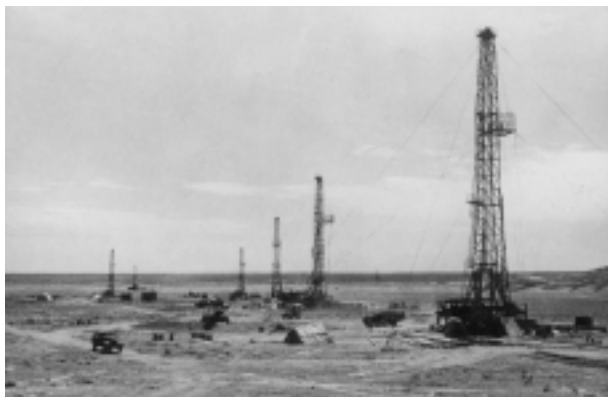
カラマイ油田での試・探掘井の掘削(上)と、現在の同油田のポンプ井による生産風景(右頁)で、生産坑井の坑口装置が狭い間隔で基盤目模様に並ぶ(『中国石油工業』より)
